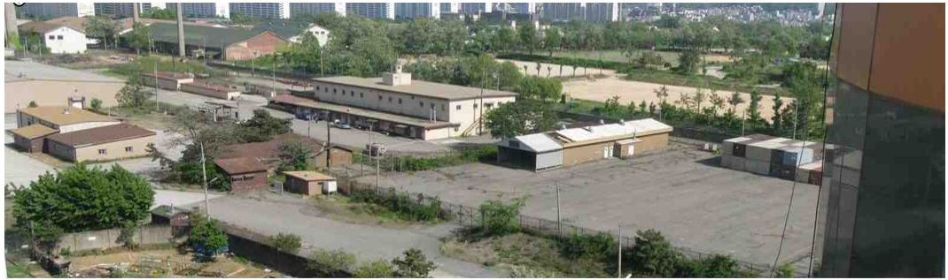
[그림-322] 대상지 전경
