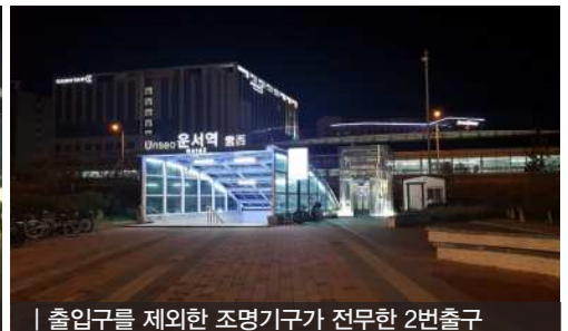
| 출입구를 제외한 조명기구가 전무한 2번출구
