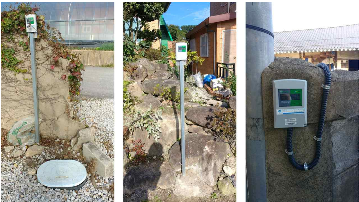
[ 그림 2 - 47 ] 고창군 수용가 공사
