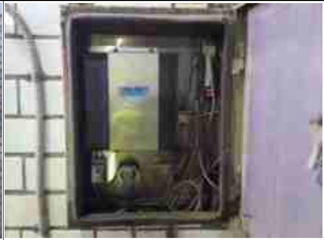
동적자동계측기(DDL-R/M, 지오넷) 및 CDMA모뎀
