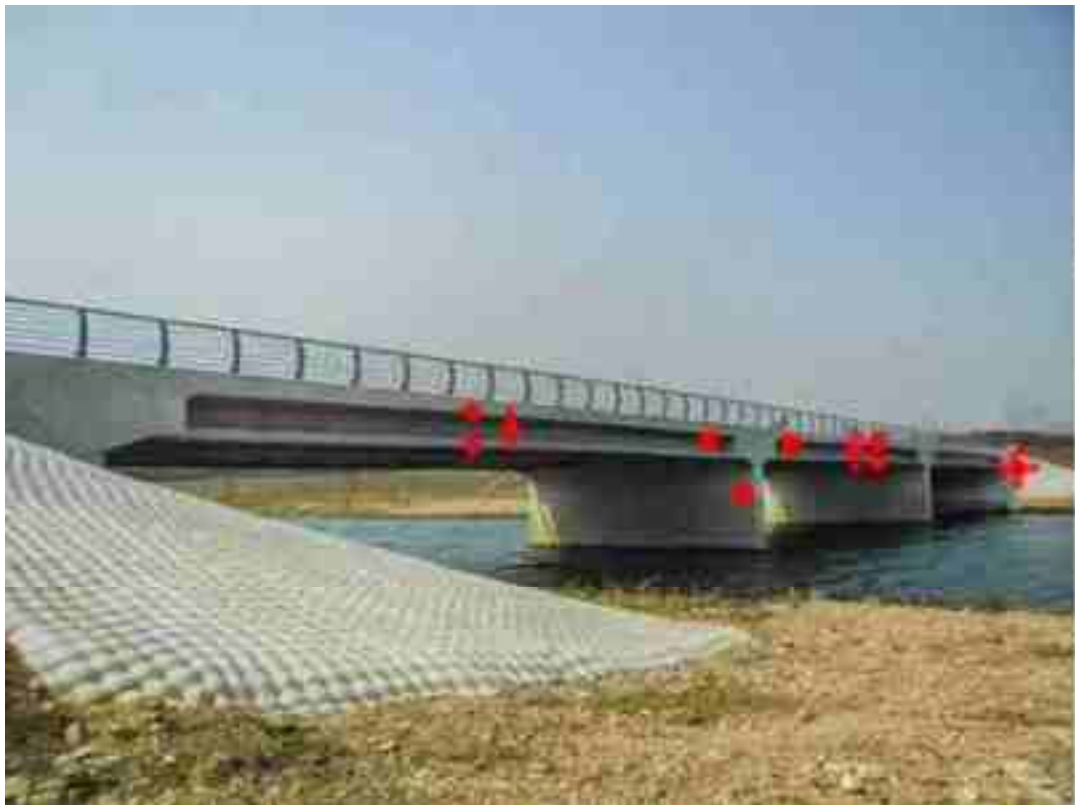
〈그림 3.1-5〉 라멘교 계측장비 설치(예)
