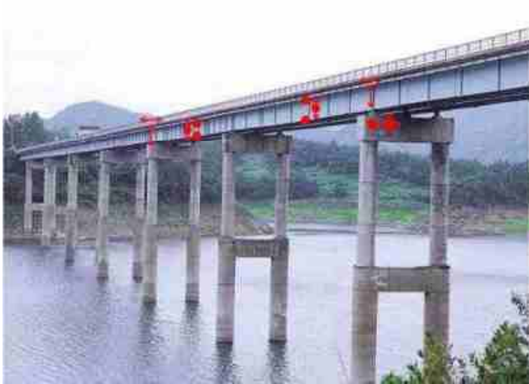
〈그림 3.1-4〉 거더교 계측장비 설치(예)
