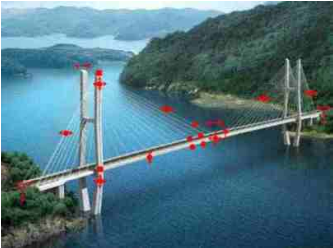
〈그림 3.1-2〉 사장교 계측장비 설치(예)
