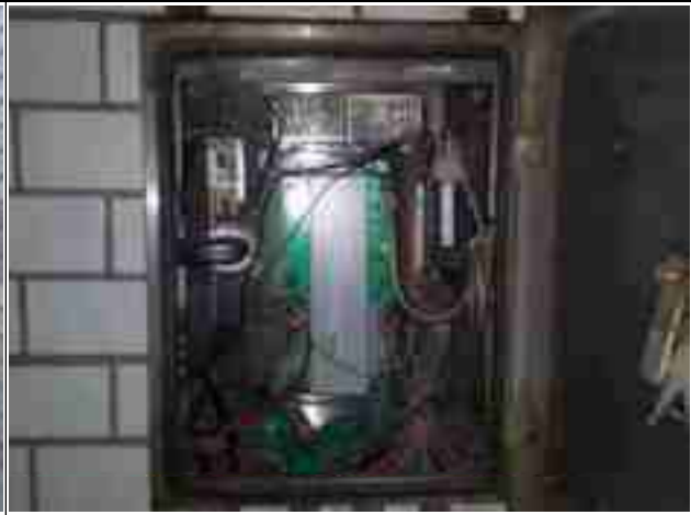
동적자동계측기(DDL-R/M, 지오넷) 및 CDMA모뎀
