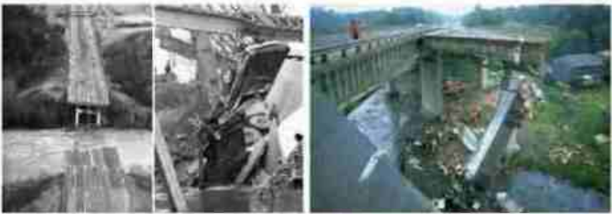
〈그림 2.2-3〉 Silver Bridge 및 Mianus River Bridge 붕괴 사례
