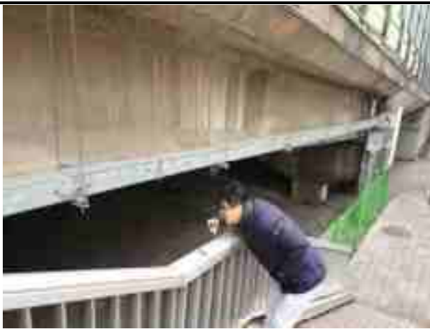
교량 노후화 점검
