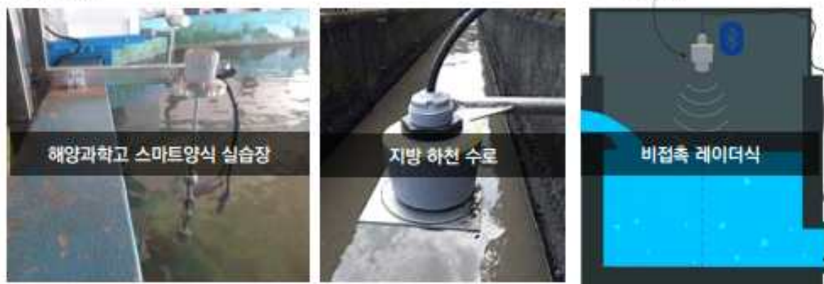
Fig. 82 수위센서 설치 예시
