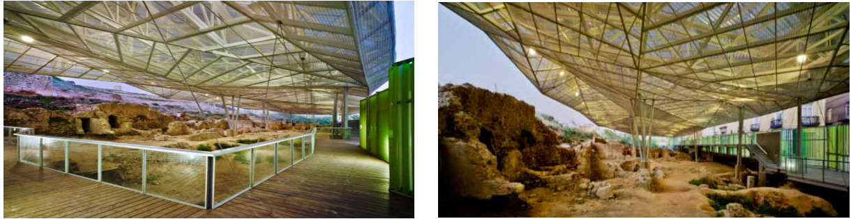
스페인 molinete park의 고대유적을 보호하기 위해 설치된 반투명 폴리카보네이트 루프 캐노피
