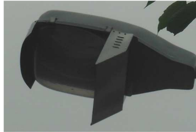
그림 5.16. 부평구 보안등 조명 개선 필요 (좌: 차광판 설치, 우: 우선지역 환경)
