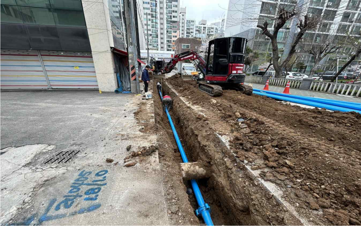
【618블록 산곡동 261-8번지 일원 노후관 교체공사】
