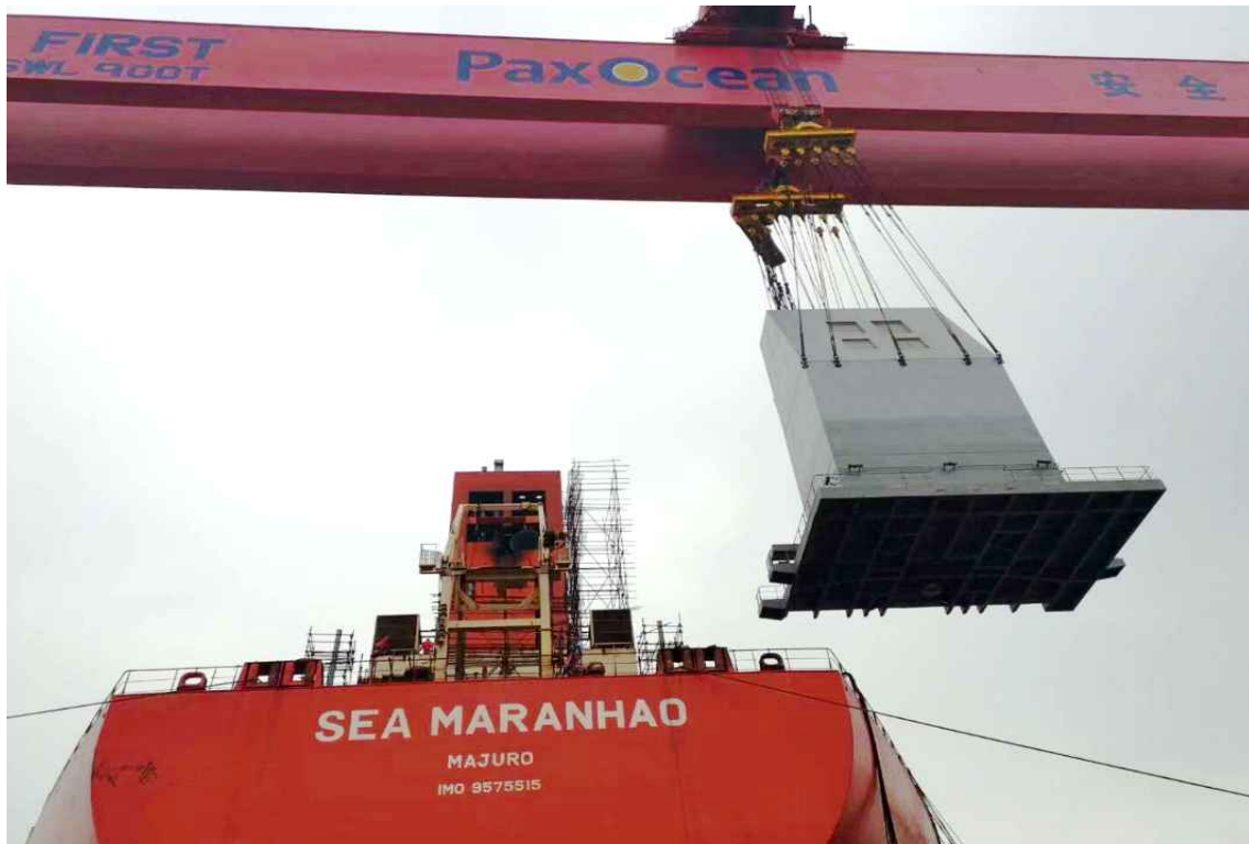
[그림 II-39] PaxOcean사의 스크러버 설치 과정
