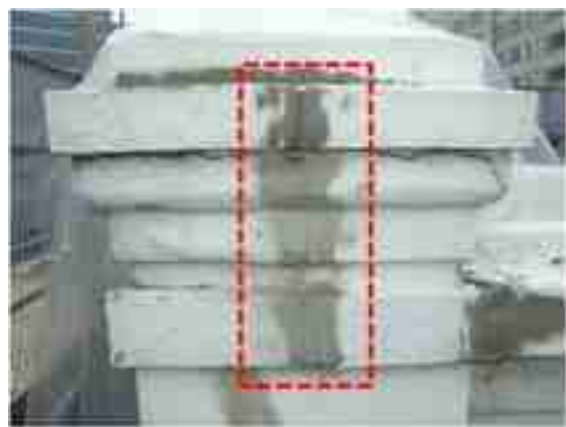
그림 3-12. 탄소섬유와 에폭시수지로 보강한 흔적
