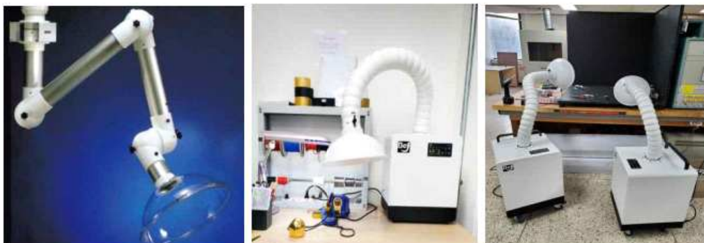
<그림 150> 암후드형 국소배기장치(왼쪽), 탁상형 국소배기장치(가운데), 이동식 스탠스형 국소배기장치(오른쪽)
