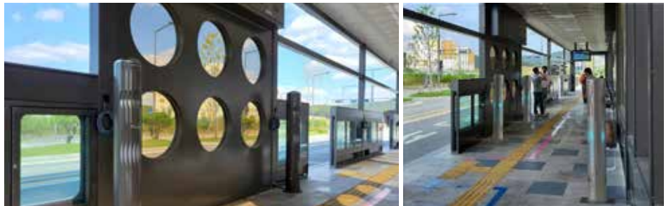
▲ 온도와 습도 등 기후변화가 큰 실외 환경에서 사용하는 대기 오염 저감 장치 '에어튜브'를 설치하여 보행자에게 깨끗한 공기 제공, 스마트 제어 기술로 원격 통합 관리
