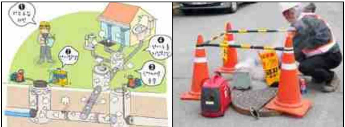
[그림 3.3-24] 오점 확인을 위한 연막검사(출처:한국환경공단, 수도씨앤지)
