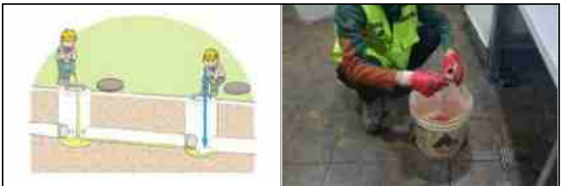
[그림 3.3-25] 오점 확인을 위한 염료검사(출처:한국환경공단, 우리건설)
