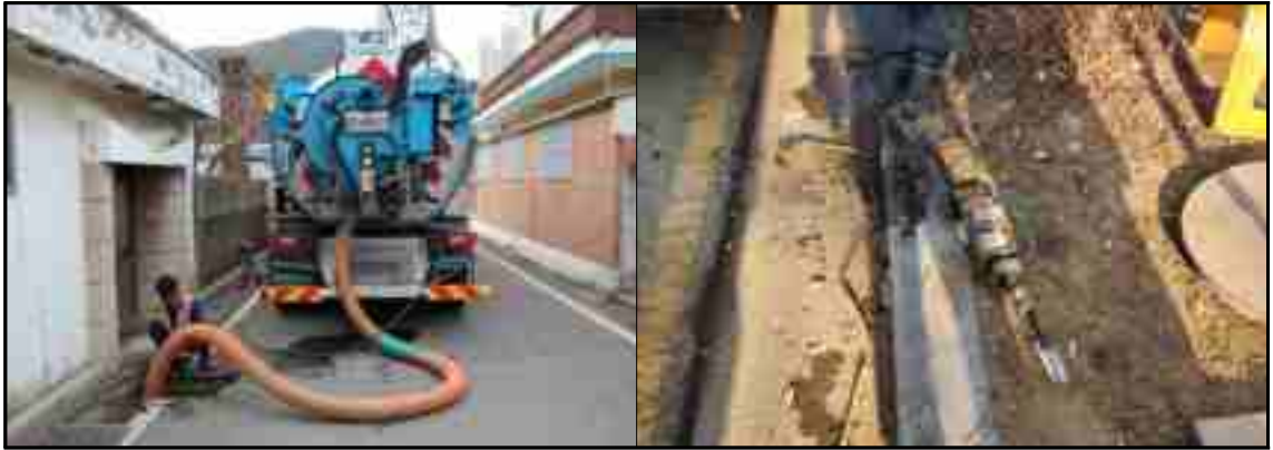
[그림 3.3-27] 퇴적물 제거(준설)(출처:수도씨앤지, 대동건설산업)
