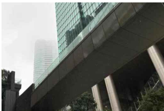
[그림 3-73] 이즈미가든 빌딩
