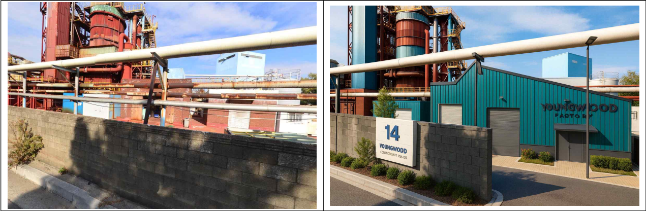
【그림 8-6】 인천지방산업단지 내 노후공장 현재 모습(좌)과 개선 후 예상도(우)
