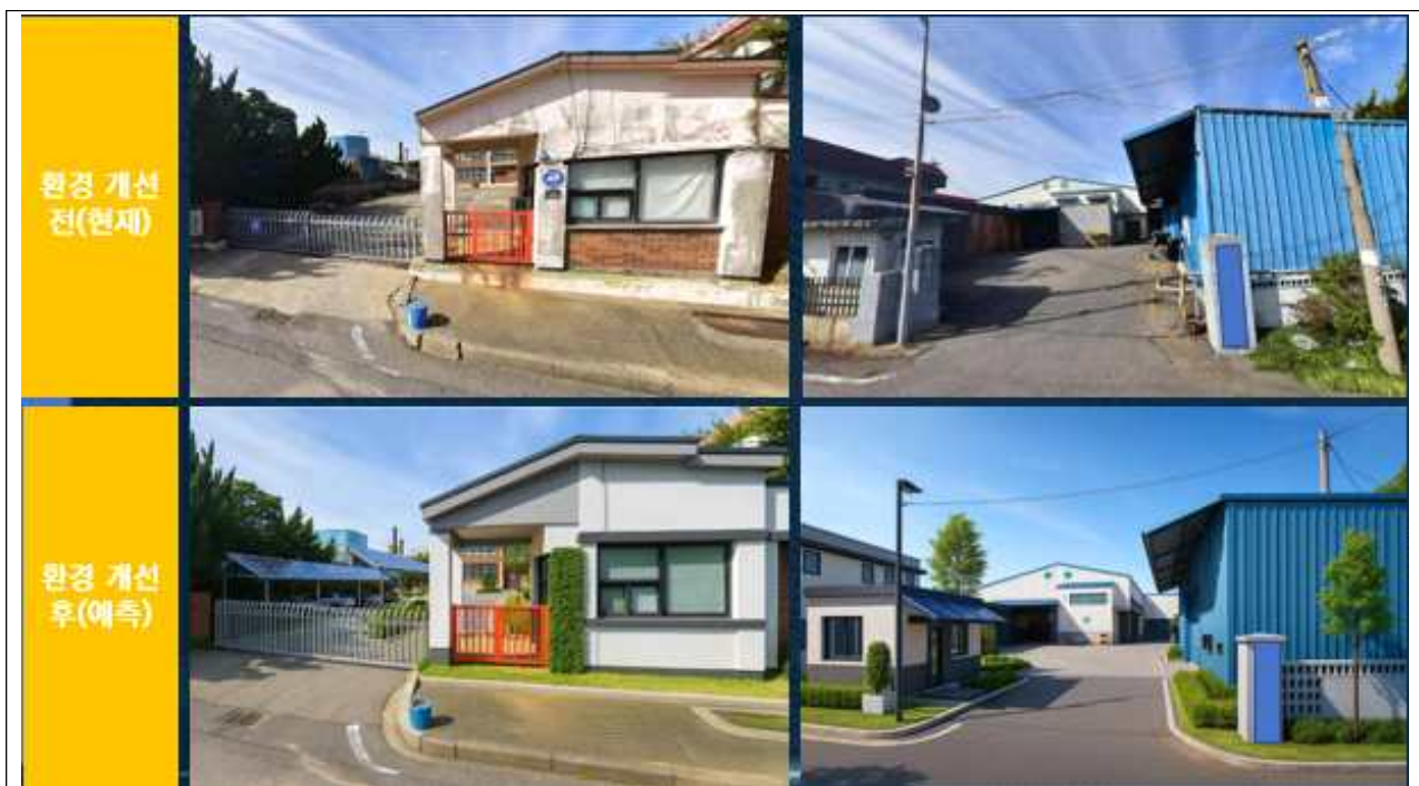
【그림 12-4】 강화하점산업단지 노후 공장 현재 모습과 외관 개선 후 예상도
