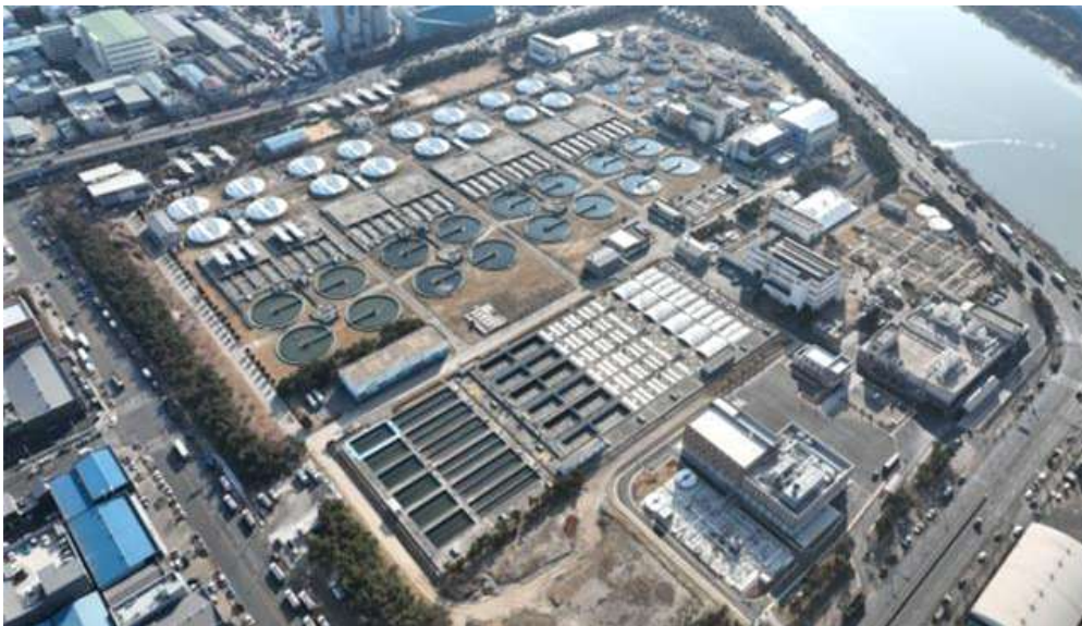
<그림 2-21> 인천 서구 가좌 공공하수처리시설 현황
