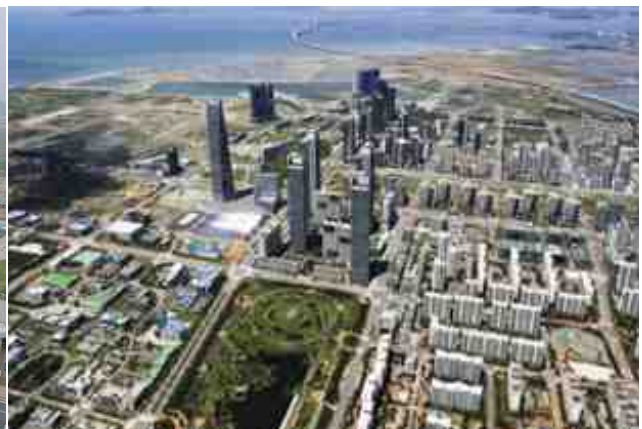
[그림-051] 송도국제도시 도시개발사업지 전경
