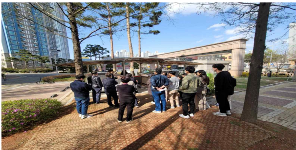
대형광량기 설치 공동주택(청라힐테스)
