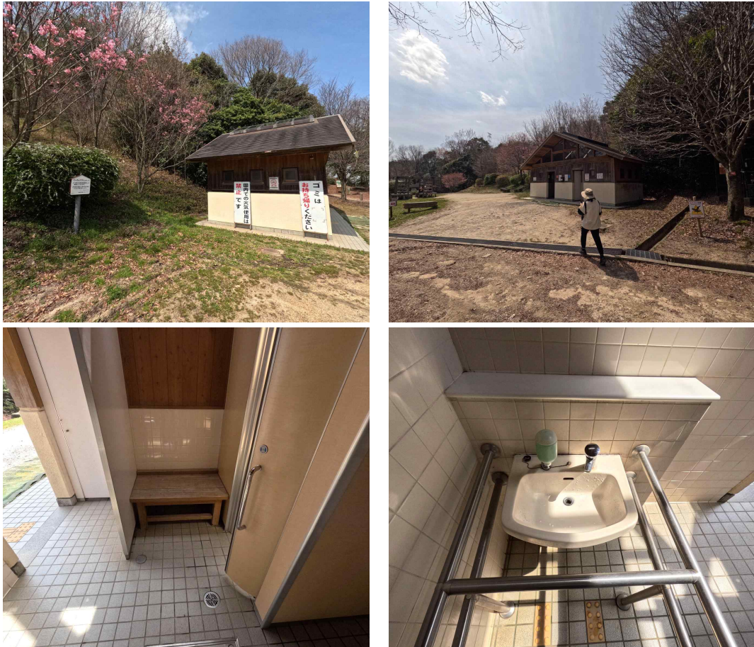
그림 73 오사카 부민의숲 호시노원지 정상 화장실 설치 상태
