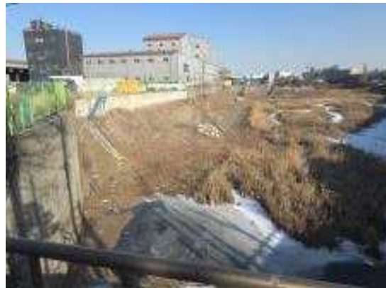
석남 유수지 말단 지점 전경
