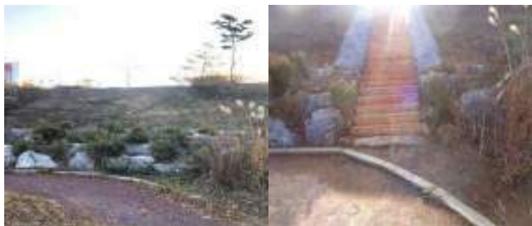
목계단 설치 전
