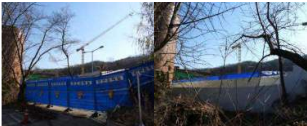
경찰종합학교 건물철거 공사현장
