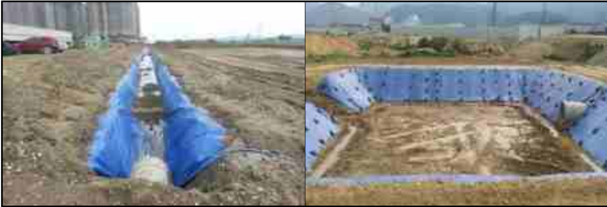
(그림 4.1.2-1) 가배수로 및 임시침사지 설치(예시)
