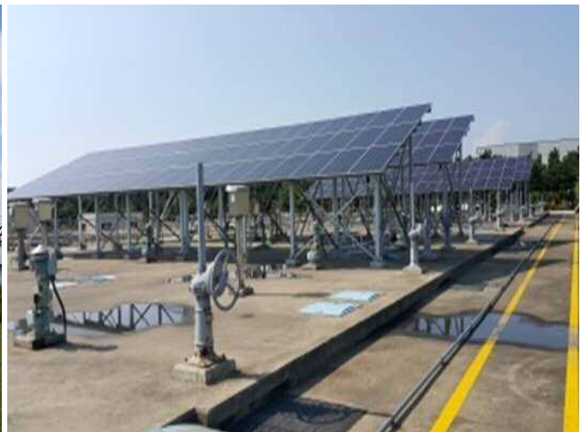
가좌하수처리시설 태양광 발전설비(100kW)
