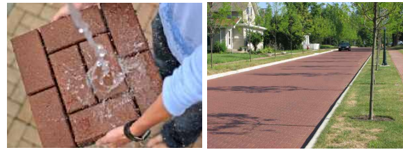
<그림 5> 투수성 포장(좌)와 적용사례(우)
