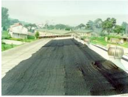
<축사지붕 및 축사내에 차광망 설치>
