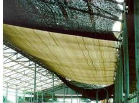
<축사지붕 및 축사내에 차광망 설치>
