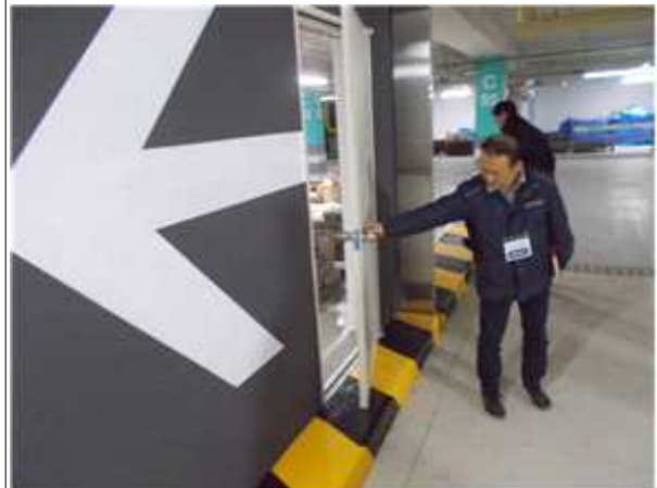
사진10 Ramp 방화 shutter 옆 비상출입문 열리지 않음 수정
