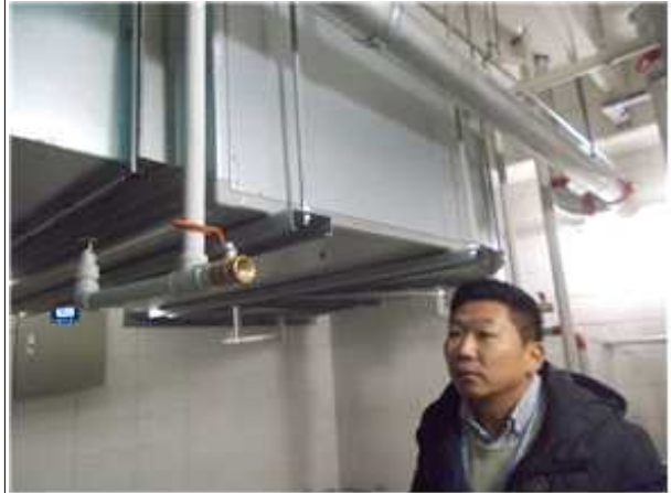
사진8 환풍 Duct 고정용 앵커 등 철물 머리 보호대 필요
