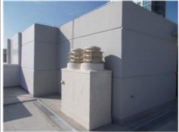
사진20 옥상 무동력 fan 벽에 근접시공, 태양광 패널 아래 시공되어 환기 불량 우려
