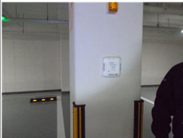
사진6 지하주차장 비상호출기 인식표시 없음 4면에서 인식 가능한 표기 필요
