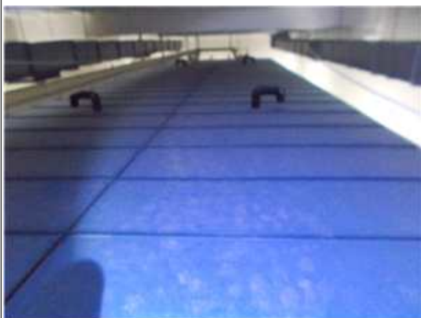
사진11 지하주차장 천장 Signboard 배관 pipe와 간섭으로 식별 어렵워 위치, 높이 조정필요
