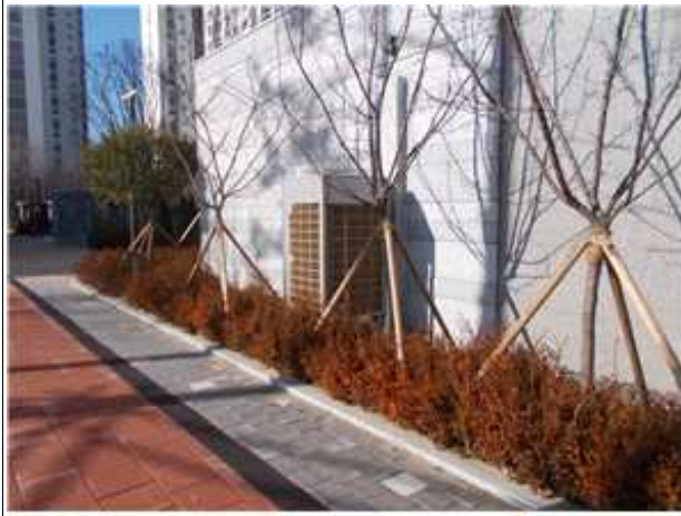
사진13 노인정 및 부대시설 실외기 조경에 노출되어 가림막 설치 필요
