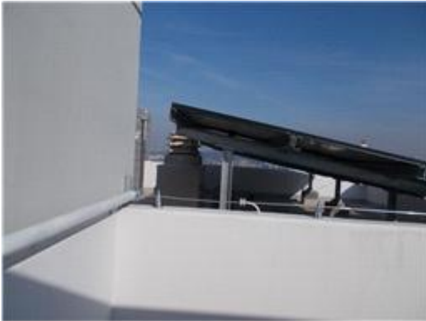
사진21 옥상 무동력 fan 벽에 근접시공, 태양광 패널 아래 시공되어 환기 불량 우려
