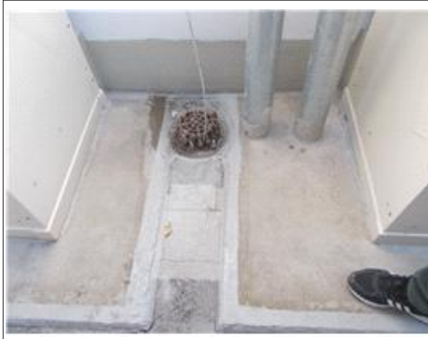
사진18 옥상트랜치 구매 및 배수구 주위 구배 수정 필요
