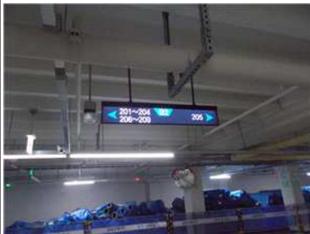
사진11 지하주차장 천장 Signboard 배관 pipe와 간섭으로 식별 어렵워 위치, 높이 조정필요
