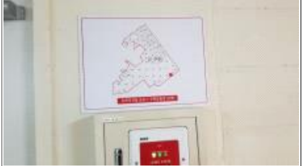
사진4(감지기 구역도 설치 )
