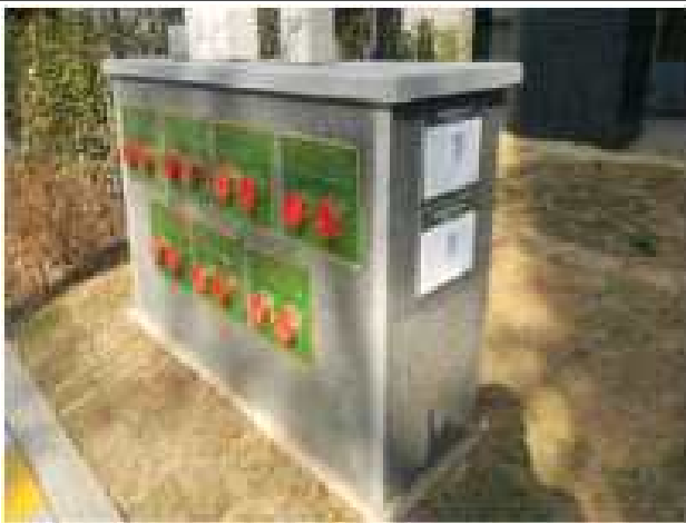
사진9(옥외 연결송수구 구역표기 및 사진)
