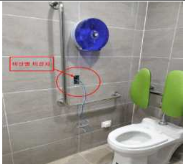
사진8: 커뮤니티실 장애인 화장실 비상벨 미설치
