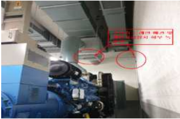
사진3: 발전기실 소음기 드레인 배관 및 매연저감장치 하부 누 발생
