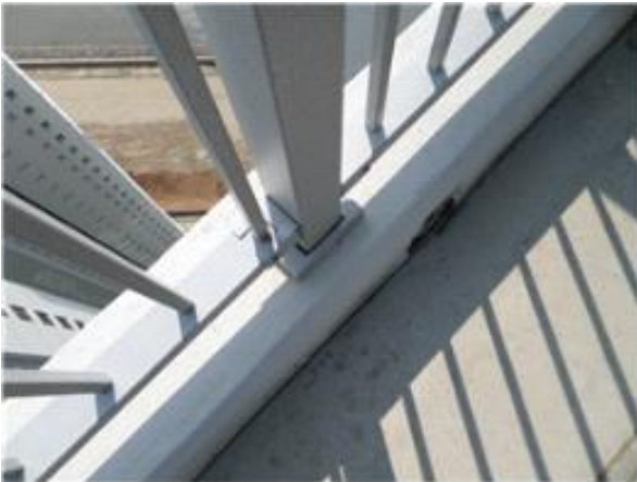
사진17 (옥상 층 Elevator 기계실 측벽 판넬 주위 마감 불량 )
