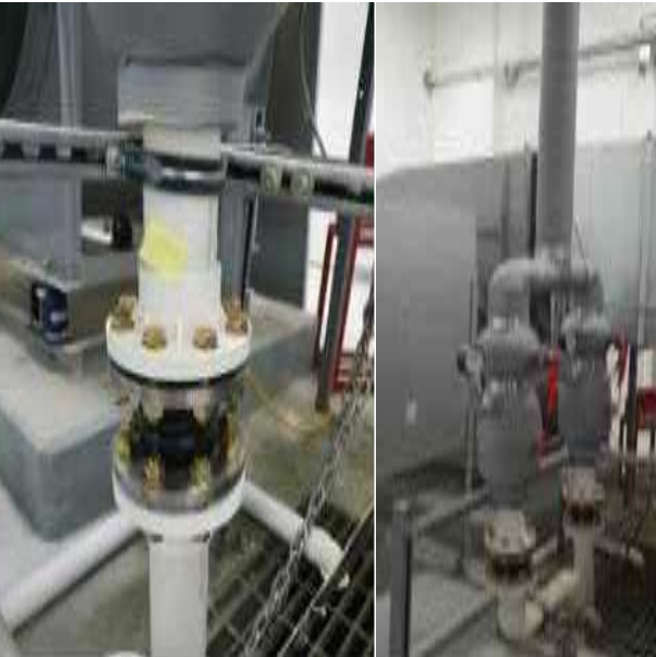
사진7(주차장 배수펌프실)배관용도, 유체흐름 표기 미실시, PVC 본딩 미흡(내부 불충분), Flange 부식방지 미조치.
