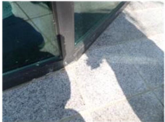
사진34 (커뮤니티 센터 외부 창호 주위 석재 코너부위 마감 처리 미비 ) 물갈기 미비
