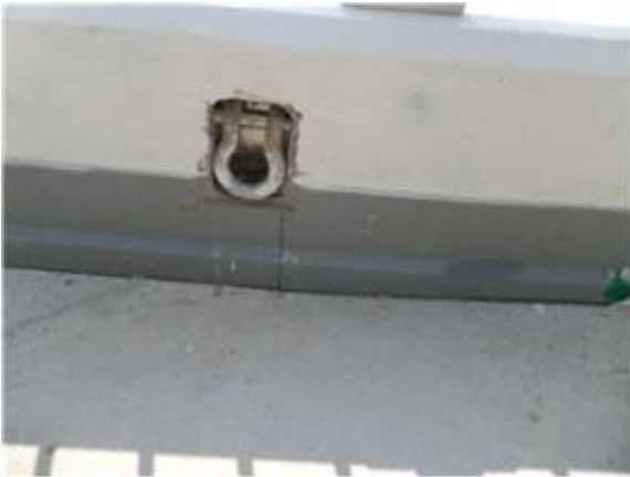
사진15 (옥상층 난간 살과 고정 캡 간섭부분 절단 후 조치 미흡으로 녹 발생 )
