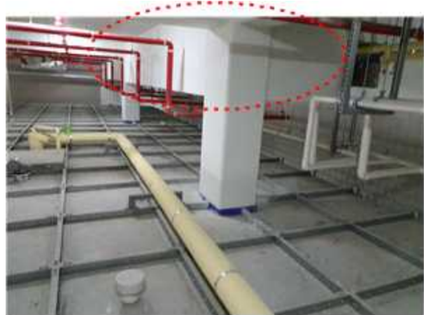
사진4(오수배관 Drain 구조 Pit) 배관 누수시 물탱크 오염방지를 위해 배관 하부에 Drain Pit 구성
