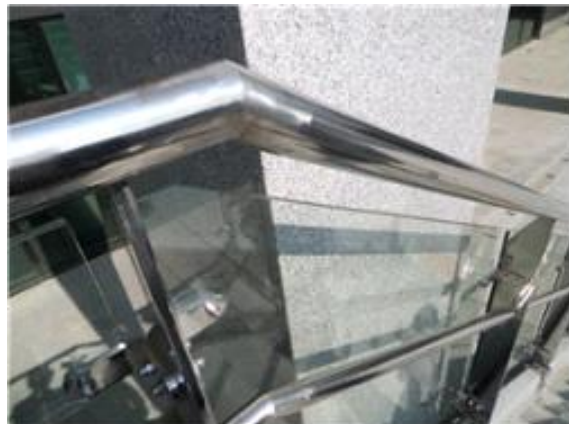
사진30 (커뮤니티 센터 sunken 핸드레일 용접부위 유광처리 미비 )
