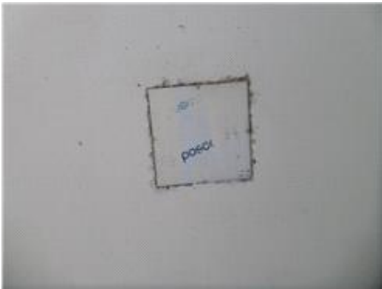
사진17 (옥상 층 Elevator 기계실 측벽 판넬 주위 마감 불량 )
