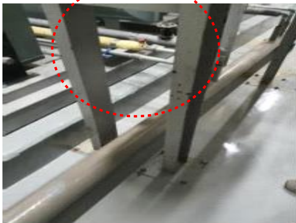
사진9(기계실 Support 도장마감 불량(녹다수 발생))
