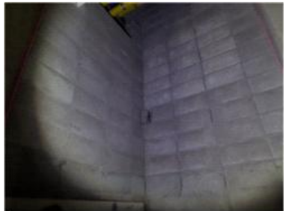
사진24 (지하주차장 105동 환풍 배관파이프 주위 paint 미비 및 블록 줄눈 불량)
