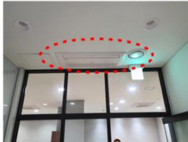
사진2(커뮤니티 룸 배기구 위치가 에어컨 근접설치로 Room Condition 불량)
