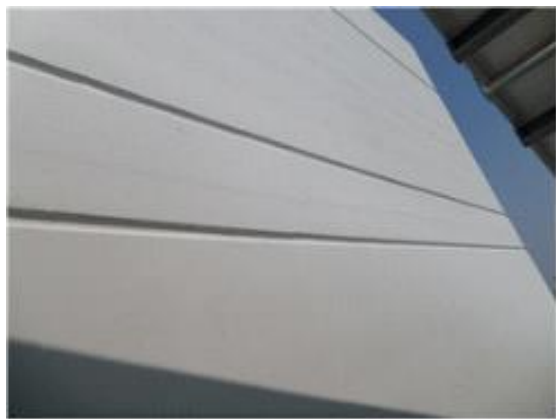
사진18 (옥상 층 Elevator 기계실 측벽 균열 ) 수평으로 균열 발생
