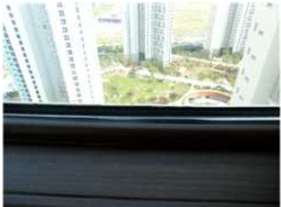
사진36 (세대내부 창호 유리 고정용 가스켓 평활도 부족 )
