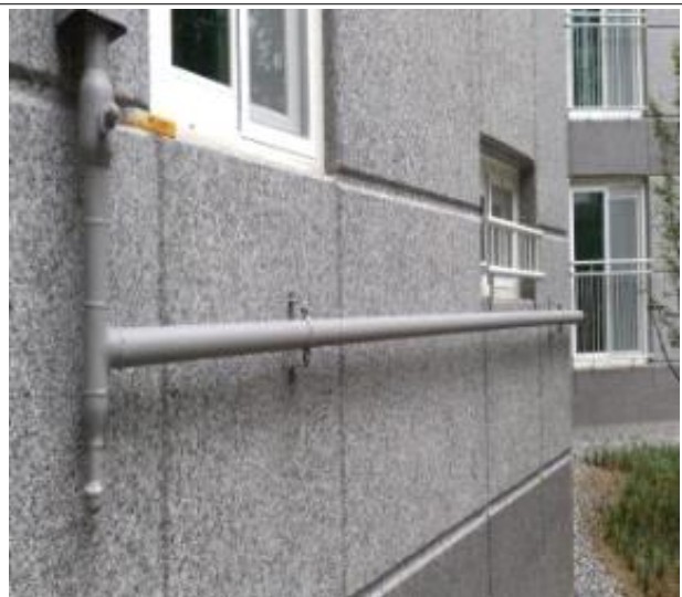
사진14(저층부 도시가스배관 방법시설 설치)
