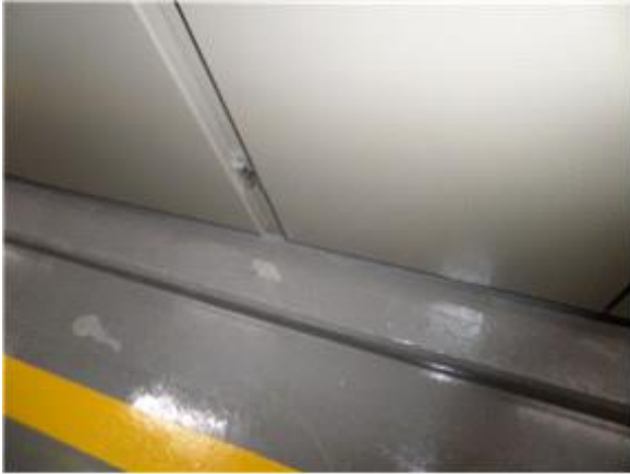
사진1 (전기실 바닥 PAD 에폭시 paint 벗겨짐 손보기 )
