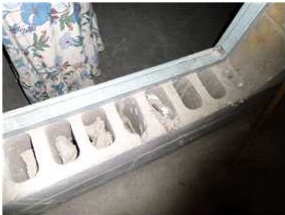
사진5 (물탱크실 옆 PIT 출입문 SILL 콘크리트 블록 구멍 쓰레기 청소 및 몰탈 등으로 마감 필요 )
