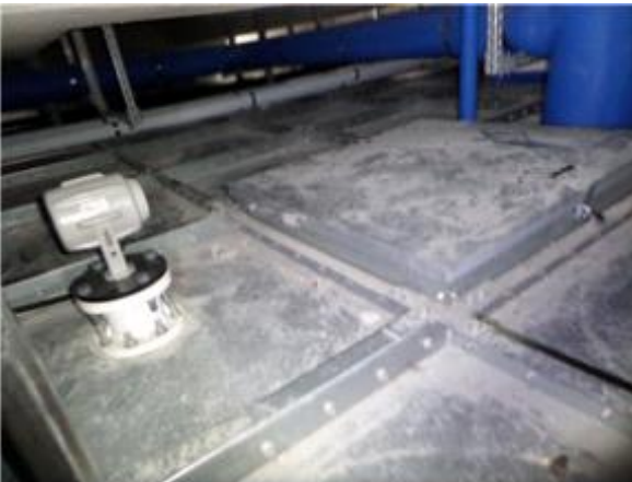
사진5 (물탱크실 옆 PIT 출입문 SILL 콘크리트 블록 구멍 쓰레기 청소 및 몰탈 등으로 마감 필요 )
