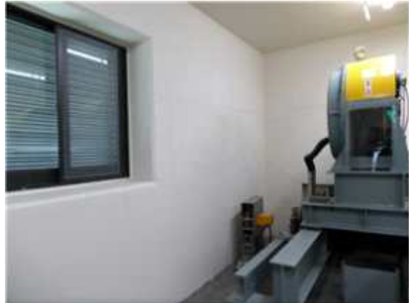
사진24 (Elevator 기계실 벽과 천장 흡음패널 미설치 됨) 걸레받이 Paint 검토
