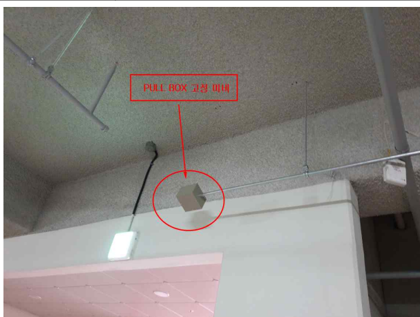
사진12 (102동 출입구 상부 PULL BOX 고정 미비 )
