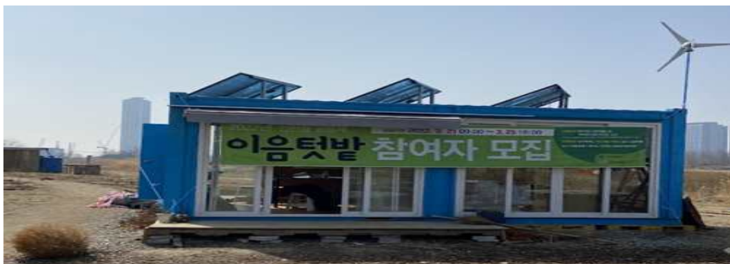
그림 4 이음텃밭 임시사무실은 소형태양광풍력발전으로 전기를 생산해서 쓴다.
