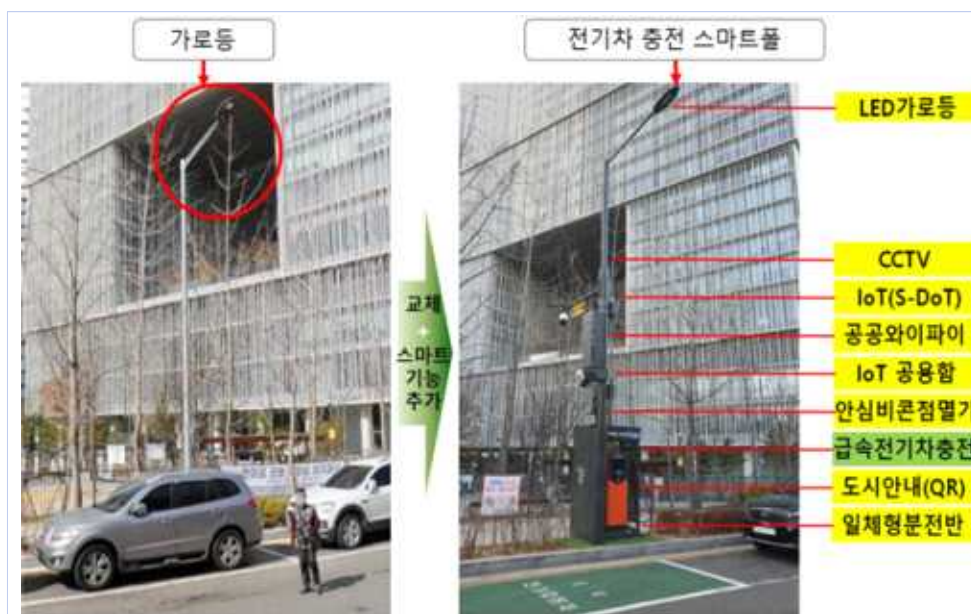
[그림 1-2] 스마트폴 구성 예) 전기차 충전 가로등 스마트폴 (출처 : 서울시)
