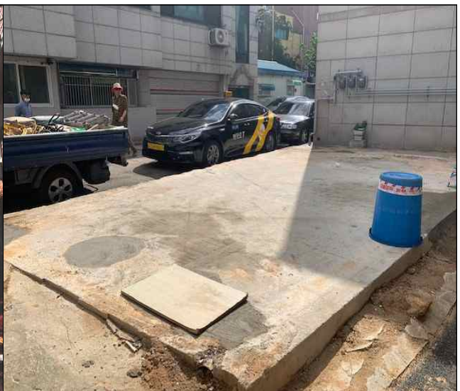
안전 조치[철거] 완료 후(8.24.) 정화조 역류 방지 안전조치 시행 (맨홀 제거 및 콘크리트 시공)
