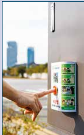
방범 CCTV 지주대에 설치된 비상벨. 유사시 벨을 누르면 운영센터 요원과 바로 연결된다.
