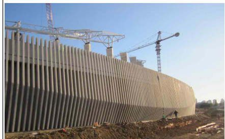
서측 외부 PC루버 설치
