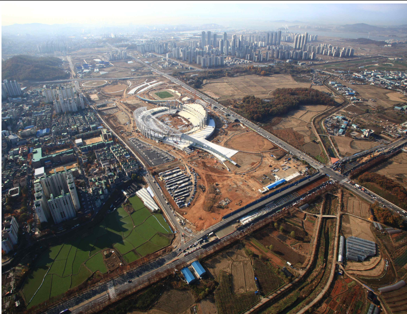
건축 공사 전경
