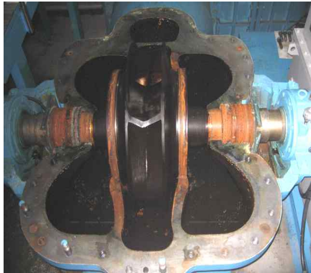
송수펌프 분해 전경
