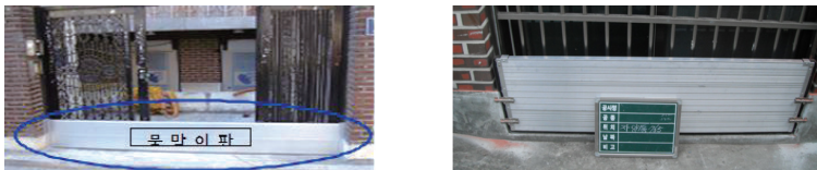
집중호우시 빗물이 노면을 율류하여 대문·창문을 통해 집안으로 유입되는 노면수 차단
