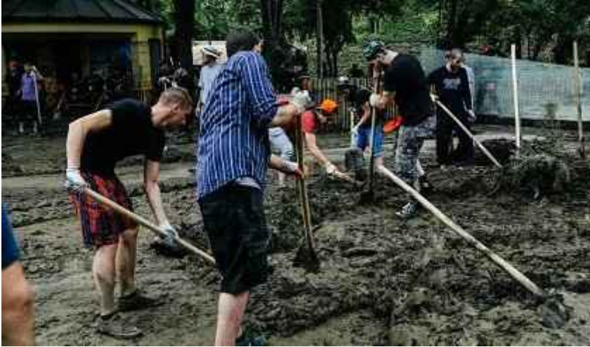
Volunteers cleaning up after last month's floods in Tbilisi, Georgia. (Photo: UNISDR) 조지아 수도 트빌리시 지난 달 홍수이후 흙더미를 치우고 있는 자원봉사자들
